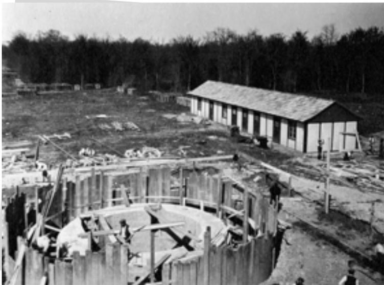
Creusement et coffrage de la tête du puits N° 1
